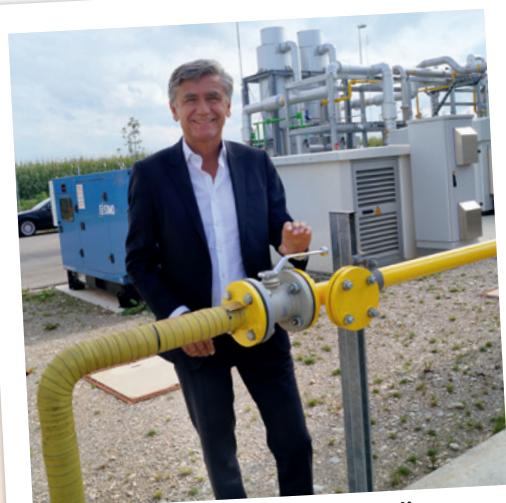
2014 Jürgen Bauer nimmt die Biogasanlage in Mammendorf in Betrieb
