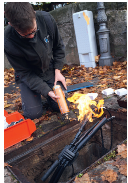
Schrumpfschläuche werden angebracht
